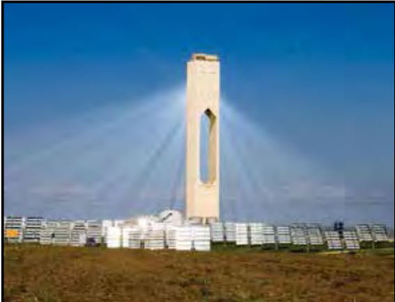
ಚಿತ್ರ 8: ಸ್ಪೇನ್‌ನಲ್ಲಿರುವ ವಿದ್ಯುತ್ ಸ್ತಂಭದ ಘಟಕ. ಕಲ್ಲಿದ್ದಲಿಗೆ ಬದಲಾಗಿ ಸೌರ ಶಕ್ತಿಯನ್ನು ಉಪಯೋಗಿಸಿ ಜನರೇಟರ್‌ಗಳಿಗೆ ಆವಿಯನ್ನು ಉತ್ಪಾದಿಸುತ್ತದೆ. ಗಾಳಿಯುಳ್ಳವು ಧೂಳಿನಿಂದ ಸೂರ್ಯಕಿರಣಗಳ ರೇಖೆ ಸ್ಪಷ್ಟವಾಗಿ ಕಾಣುತ್ತದೆ. ಕೃಪೆ http://en.wikipedia.org/wiki/PS10_solar_power_plant#/media/File:PS10_solar_power_tower.jpg
